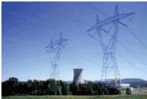
Γραμμή μεταφοράς 400 kV
