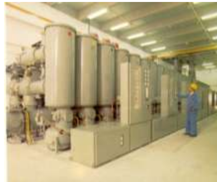
Ζυγοί και διακόπτες 170 kV με μόνωση αερίου SF 6 (GIS)
